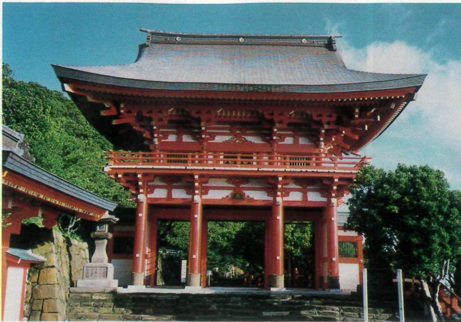
新装なった楼門
