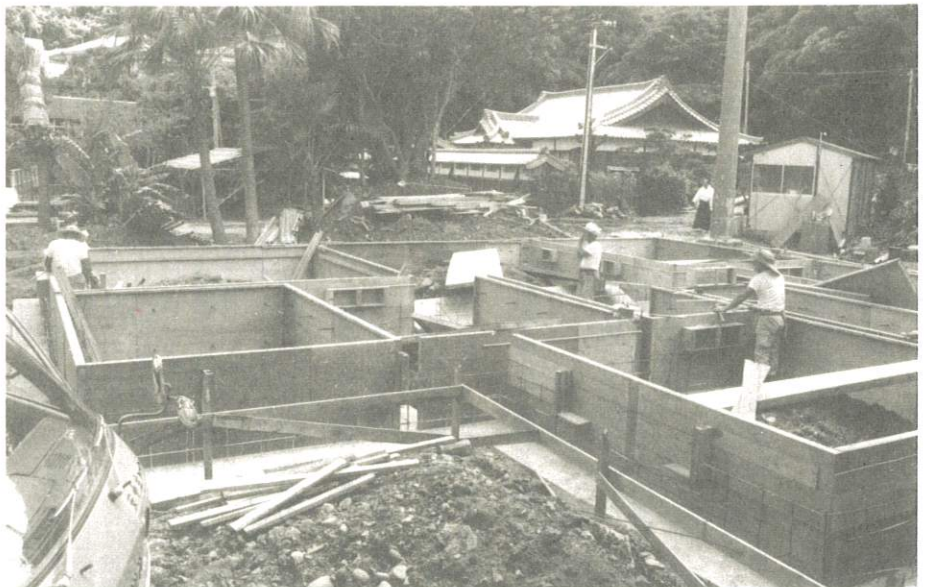
進行中の齋館工事
