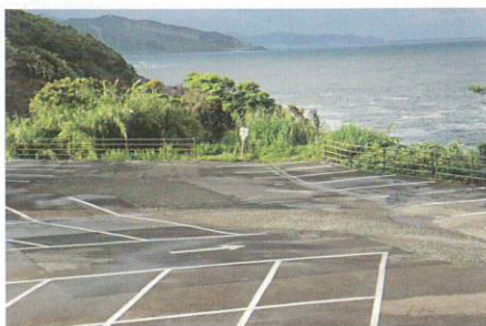
令和元年 11月13日修復後
